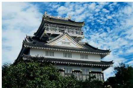
岐阜市のシンボルとなっています 【写真提供～岐阜市】
